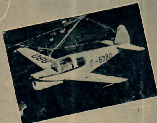
Nord 1200 Norecrin. Tre-sitsigt helmetallplan med 140 hk Renault-motor. Marschfart 230 km/t, landningsfart 75 km/t, flygsträcka 950 km.
