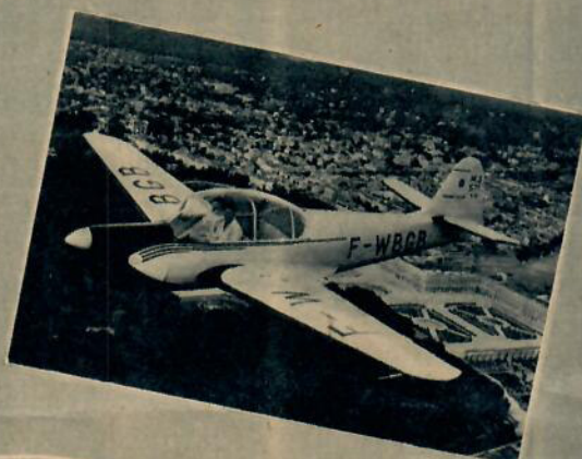
Morane Saulnier 571. Tre-sitsigt helmetallplan med 140 hk Renault-motor. Marschfart 220 km/t, stighastighet 5 m/sek, flygsträcka 1 000 km.
