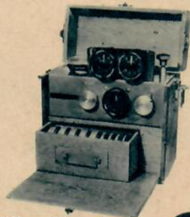
Diameterprovare för differential-tryck
