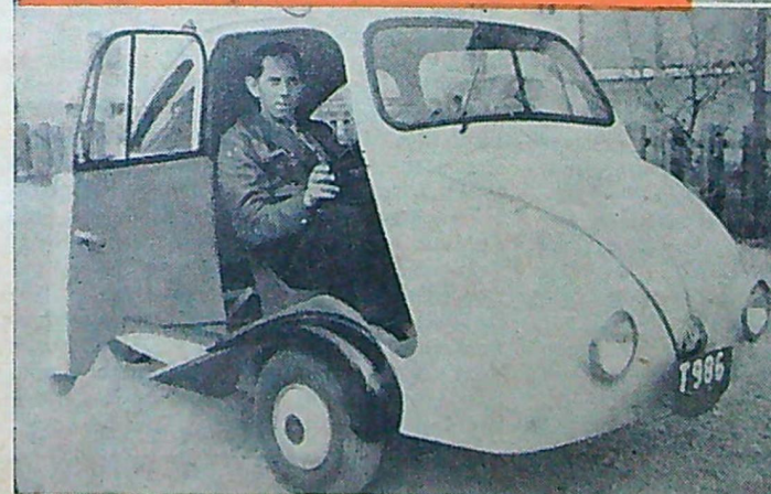
Gemo-vagnens tilltalande yttre. Till vänster ses konstruktören själv, herr Gösta Mollberg, demonstrerande att man sitter bekvämt, har god sikt och kommer lätt i och ur vagnen. Övan Gemos linjerena front. Till höger är motorhuv upplyft och man ser att motorn ligger väl skyddad från skakningar på bakhjulet, som fjädrar i de två olika specialtillverkade fjädersystemen.
