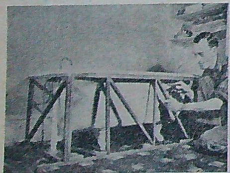
Diagonalerna som förstärker ramverket ska skruvas fast och inte spikas.
