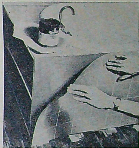
Fastsättning av linoleumplatta på främre inklädnaden.
