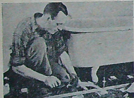
Fastspikning i golvet av 1" x 1" list, som ingår i ramverkets botten. Observera lodet!
