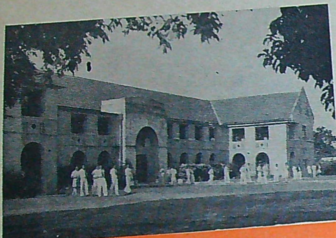
Elevehemmet vid Högskolan i Yaba, Nigeria, som är en av Afrikas modernaste högskolor. Hela anläggningen består av sex liknande byggnader.
