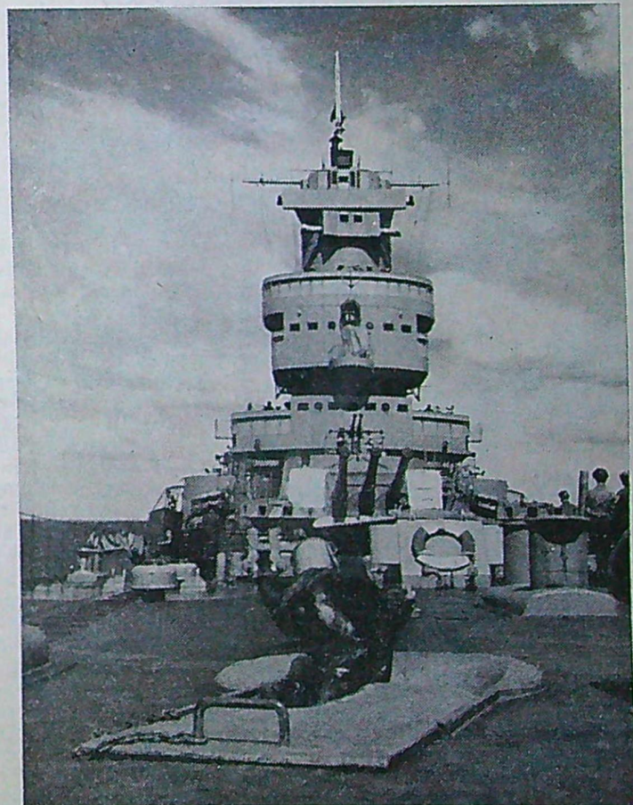
En bild av Tre Kronor tagen från fördäck. Längst fram under bryggan ett batteri bestående av tre automatiska 15 cm kanoner, som har den högsta eldhastigheten i världen för kanoner av denna storleksklass. Tre Kronor för ytterligare två batterier på vardera två sådana kanoner.
