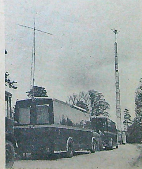
T. v.: En av BBC:s televisionspatruller. Främst upptagningsvagnen, därefter sändarvagnen och längst fram antennvagnen. T. h.: En upptagning från en boxningsmatch i London, och därovanför en upptagning i det fria — på en av Englands otaliga kanaler.
