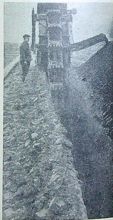
För upptagandet av rörgraven använde man sig av specialmaskiner av den typ som återfinnes på bilden.
