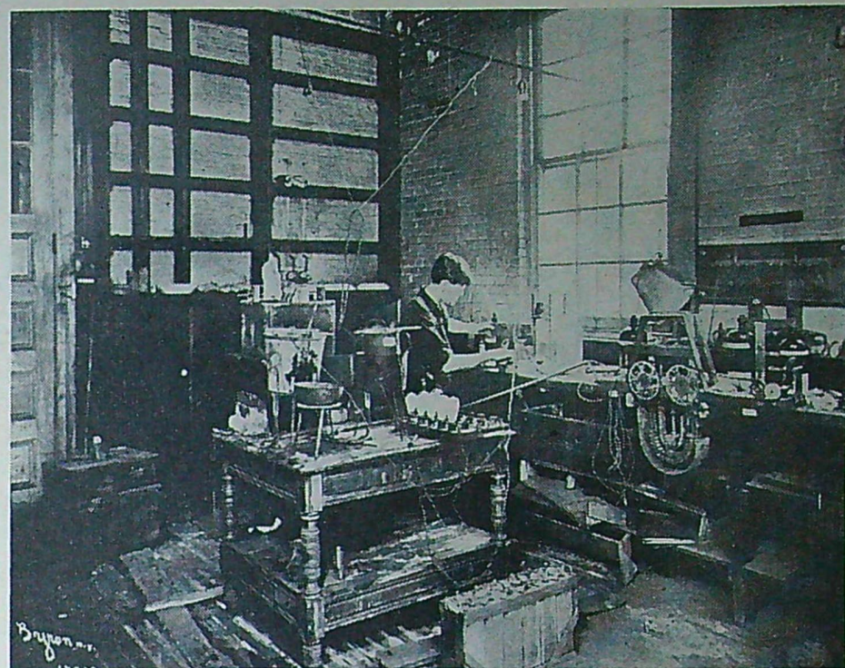
Ovan: En tidig bild från galvaniseringsrummet i Edisons New Jersey-laboratorier. Glödlampor provas med hjälp av torrbatterier.
