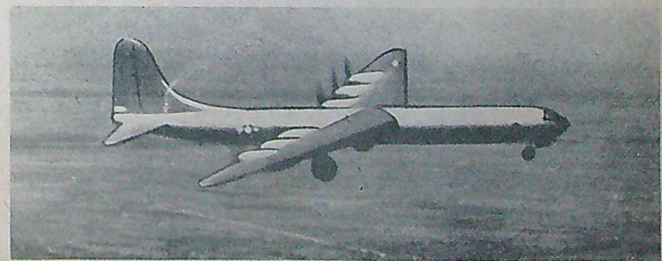
Bildet viser verdens største landfly, the Consolidated XB36. Dette bombeflyet har et vingespenn på 230 fot. Det er 163 fot langt og rorets høyde er ikke mindre enn 47 fot og 6 tommer. Det drives av 6 Pratt and Whitney-motorer, som sammenlagt utvikler 18 000 hk. Bomberen kan ta en vekt opp til 30 tonn. Mannskapet utgjør 15 mann. Propellene er av den trebladete «pusher»-type.
