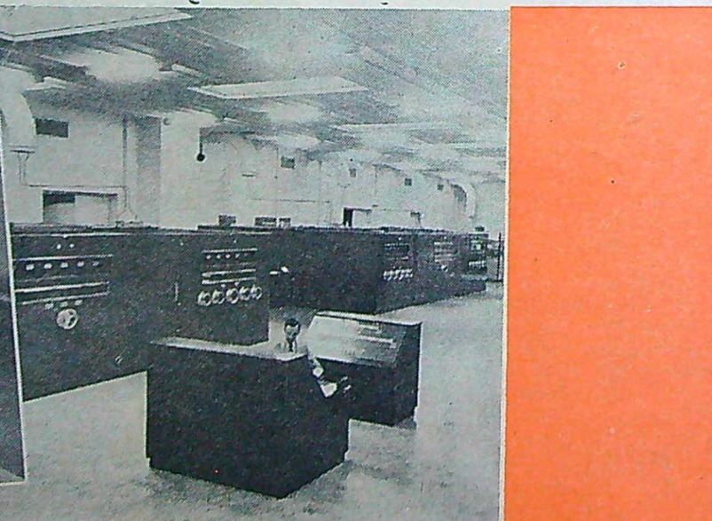
T. h.: Sheppartonstationens i Australien byggda 100 kW sändare. Nedan: Sändarhallen med de två 100 kW sändarna i förgrunden och 50 kW sändaren i bakgrunden. Inbyggda är modulator och strömkälla.
