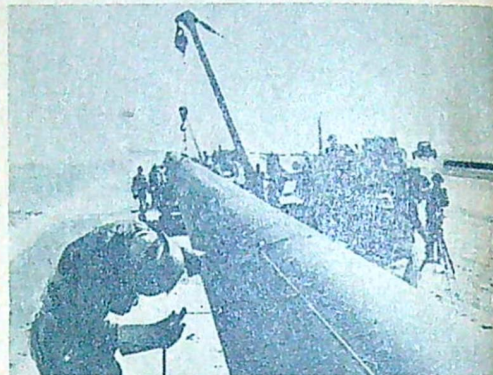
Ett invecklat transportproblem är löst. Rören är äntligen på sin plats och svetsas ihop.
