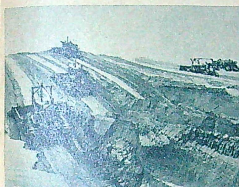
Kraftiga vägmaskiner jämnade marken för pumpstationer som byggts efter ledningen.
