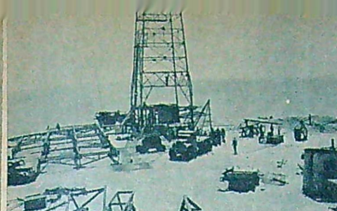
Borrtornen var transportabla med hjälp av de största däck som tillverkats. De var 3 m i diameter och vägde ca 3½ ton vardera.
