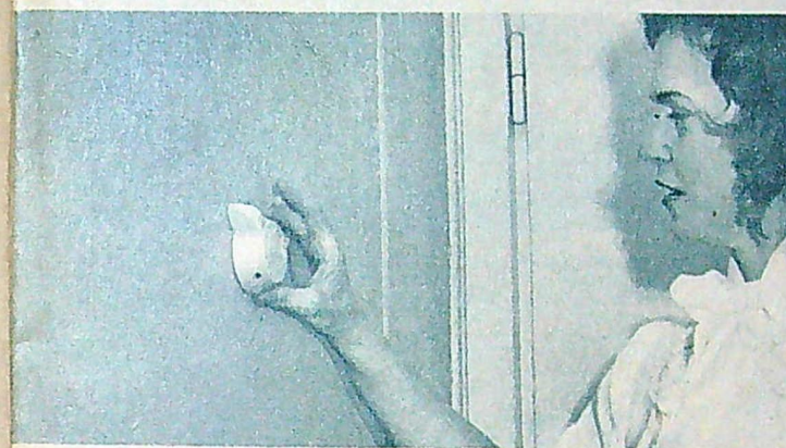
Fru INGEGERD ERLINGSJÖ reglerar med denna ratt, som styr ett spjäll i friskluftsintaget, tillförseln av frisk luft. Ratten sitter på ett skåp och över detta, osynligt på bilden, finns ett returluftsgaller.
