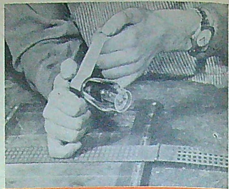
Med hjälp av blindskrift — inom parentes sagt en uppfinning av den blinde fransmannen Braille — på tape märker den blinde radioreparatören losstagna rör med påskrift om typ och plats i radion.
