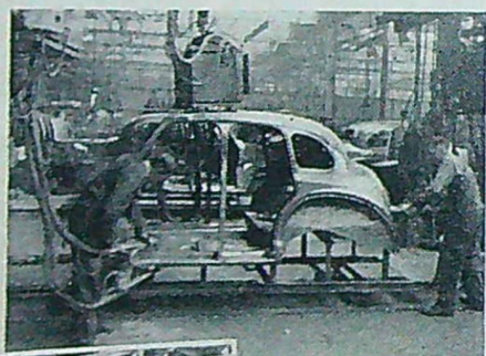
Varje plåt pressas med 20 tons tryck.
