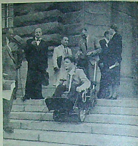
Ovan rullstolen som går i trappor. Genom en bandanordning kan en vanlig rullstol sänkas så att den tar sig upp för och ned för en trappa. T. v. en anordning för att dricka ur glas, när händerna inte kan användas till lyftande rörelse.
