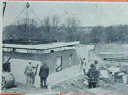
Formarna hålls vid vanlig "stående" betonggjutning samman i hörnan av lufttrycket — det är nämligen vakuum i de slangförsedda lådorna.
