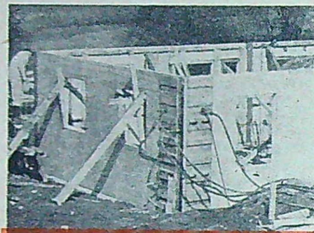
Formarna hålls vid vanlig "stående" betonggjutning samman i hörnan av lufttrycket — det är nämligen vakuum i de slangförsedda lådorna.
