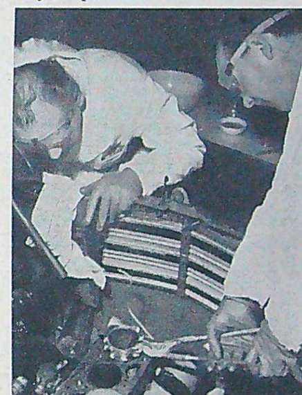
Ingenjör Persson och verkställare Jansson monterar in en kolv med radioaktiv kolring i bilen. Bägge är försedda med specialglasögon till skydd mot gammastrålningen.
