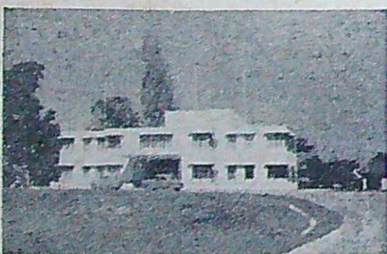
En bild av radiohuset i Kuching, Sarawak.
