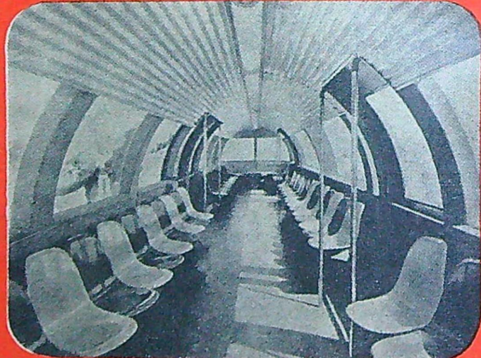
Interiören i Houstonbanans vagnar är luftig och ljus med sittplatser i fiberglas. Sittplatser finns för 60 passagerare och stäplatser för 50.
