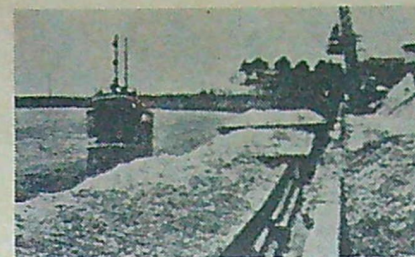
Kalk från ostronskal spelar en stor roll när det gäller att extrahera magnesium från havsvatten.
