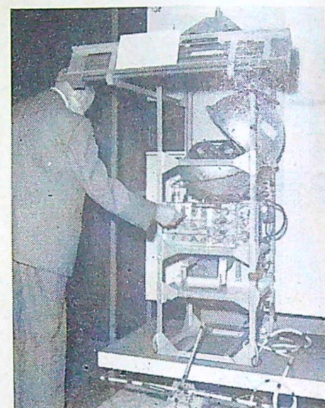
Ett ballongburet apparatkomplex för registrering och mätning av kosmisk strålning, utställt av USA:s atomkommission.
