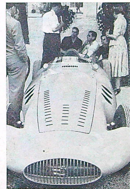
Gordini formelracer är ett formfulländat fart-åk, försett med en 8-cylindrig V-motor med Bosch direktinsprutning.
