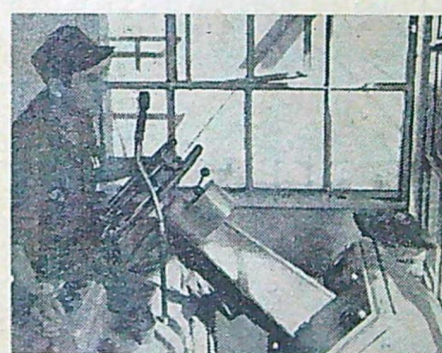
Från en hytt på vardera sidan av grävmaskinens arm dirigeras skovelhjulets hastighet, grävdjupet m. fl. detaljer.
