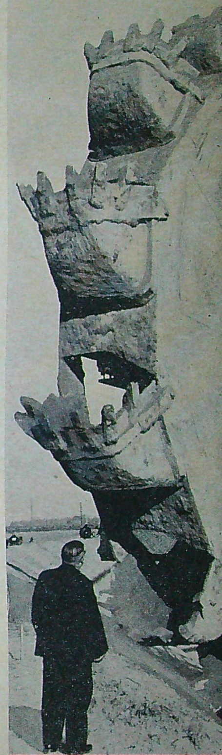
16 meter i diameter mäter det med 12 skovlar försedda skovelhjulet på "Världens största grävskopa", maskinen som i sin helhet väger omkring 5 500 ton.
