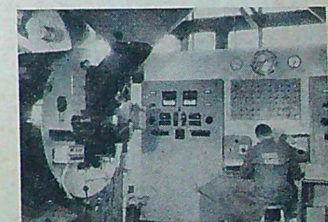
En av rostmaskinerna t. v. och instrumentpanelen för automadriften. Den unge mannen behöver endast slå till och ifrån huvudströmbrytaren morgon och kväll samt för övrigt övervaka. Det är programverken som tänker.
