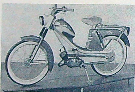
MONARK LYX. Motor: Ilo — 2-växlad — kickstart — stoppljus. Fjädring: Teleskopgaffel fram — swinggaffel bak. Tank: 5,5 liter. Ringdimension: 23"X2.25". Riktpris: 1 095 kr.
