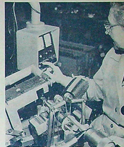
Av stor betydelse för maskinernas gång är att de är statiskt och dynamiskt väl balanserade. Balanseringen sker i en speciell apparat som ger utslag på de båda visarinstrumenten till vänster. Man eftersträvar givetvis en absolut vibra- tionsfri gång hos handbormaskinen.
