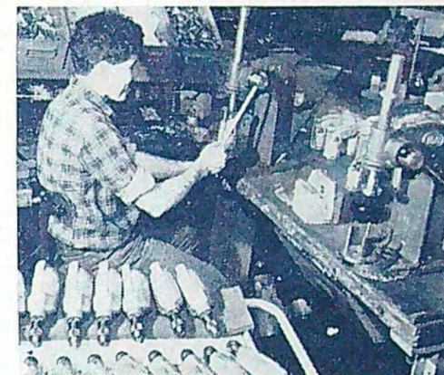
En av de allra sista etapperna i monteringen: Påsätt- ning av maskinkåpan. Denna är utförd i aluminium- gjutgods. Efter denna procedur återstår endast påsätt- ning av kabel med tillhörande stickpropp, varefter handbormaskinen är klar för de omfattande slut- proven, vilka visas på den stora bilden på sidan 14.
