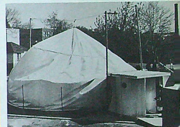
Det tar bara sex minuter att resa det kupolformade planetariet. Plasttältet, som kostat 10 000 dollar, kan lätt flyttas och snabbt resas på en annan plats.
