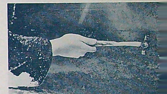
Knaeka försiktigt på bottenborden med en hammare. Ett klart och hårt ljud tyder på att träet är i gott skick, medan ett dovt ljud kan tyda på röta.
