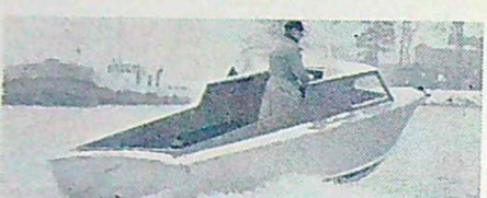
En 40 hk Perkinsdiesel med drivaggregat av utbordartyp testas nu av AB Industriediesel och båtbyggaren Owe Forslund hoppas få fram ekipaget på bilden i seriebygge. Kabinbåten mäter 6x2,1 meter.
