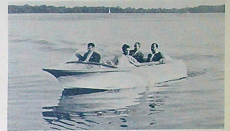
Osttyska båtvarv visade en rad båtar från stora kabinbåtar ner till små sportbåtar. Viola heter denna sportbåt, som är byggd med skrovet i 2,5 mm svetsad aluminium. Båten lämpar sig för utombordsmotorer på upp till 80 hästkrafter.
