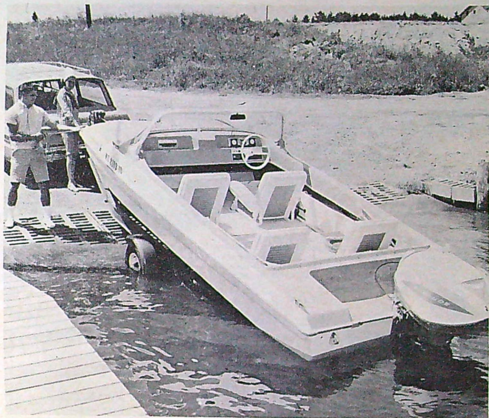
Detta är en typisk amerikansk sjösättningsramp för snabb och smidig uppdugning och sjösättning med trailer. Man använder sig här av grova järntrallar, men betongplattor är också mycket vanliga.
