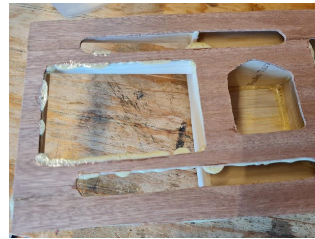
För att det skall bli bra behövs litet press på limfogen i 6 timmar. Om man skär "limskägget" inom 10-12 timmar är det lättast att få det snyggt. Efter ett dygn har PU-limmet fått sin slutliga hårdhet.
