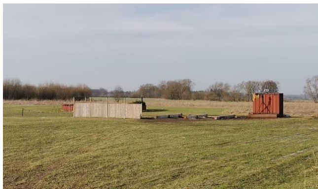
Rivning och sanering är utförd
