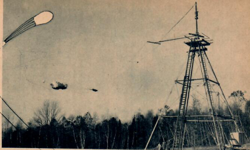
Teckningen visar det första provtornet som byggdes 1940, och här ovan ett foto av den konstruktion som nu är i bruk.
