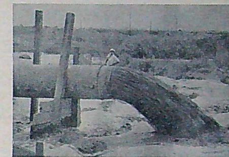
En bild från områdets utfyllnad. Sammanlagt pumpades över 30 milj. m 2 sand från Jamaica-viken ut över området.
