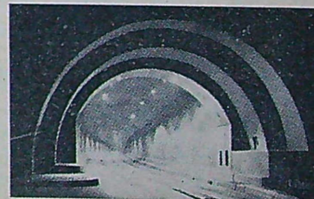
Det inre av en tunnel.
