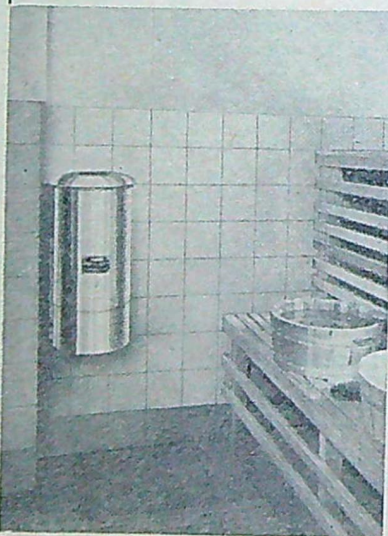
BAHCO elektriska torrbastuberedare för 5, 7 eller 10 kW, 3-fas 220/380 V.
