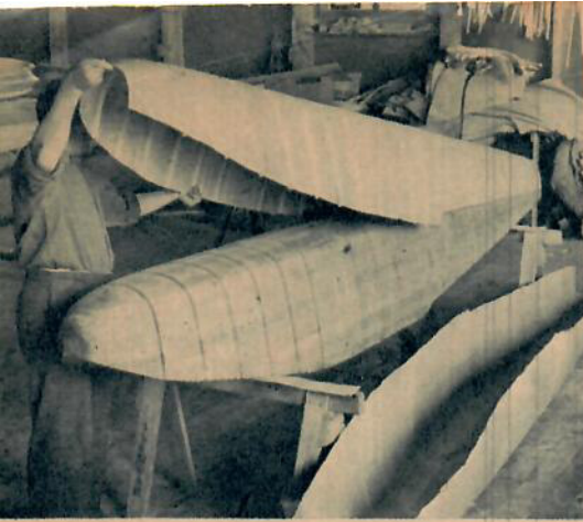
Ovan: Det färdigbakade flottörskalet och bakningsmallen. — T. h.: Kockums Flygindustri Luscombe Silvalre blir det första flygplan som utrustas med de nya träflottörerna.
