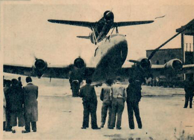
T. v.: Bristol Brigand, ett nytt tvåmotorigt attackflygplan för tre mans besättning. Planet skall efterträda Beaufighter som vann så stora lagrar under de nattliga flygstriderna över England. Beväpningen består av raketprojektiler under vingarna, fyra 20 mm:s automatkanoner på flygkroppens undersida och dessutom en rörlig kulspruta. Motorerna är Bristol Centaurus 57 med 18 cylindrar och en effekt på 2.500 hk. — Nedan: Första flygproven har gjorts med ett nytt franskt reaktionsflygplan — LEDUC 70 — som fick starta från ett transportplan.
