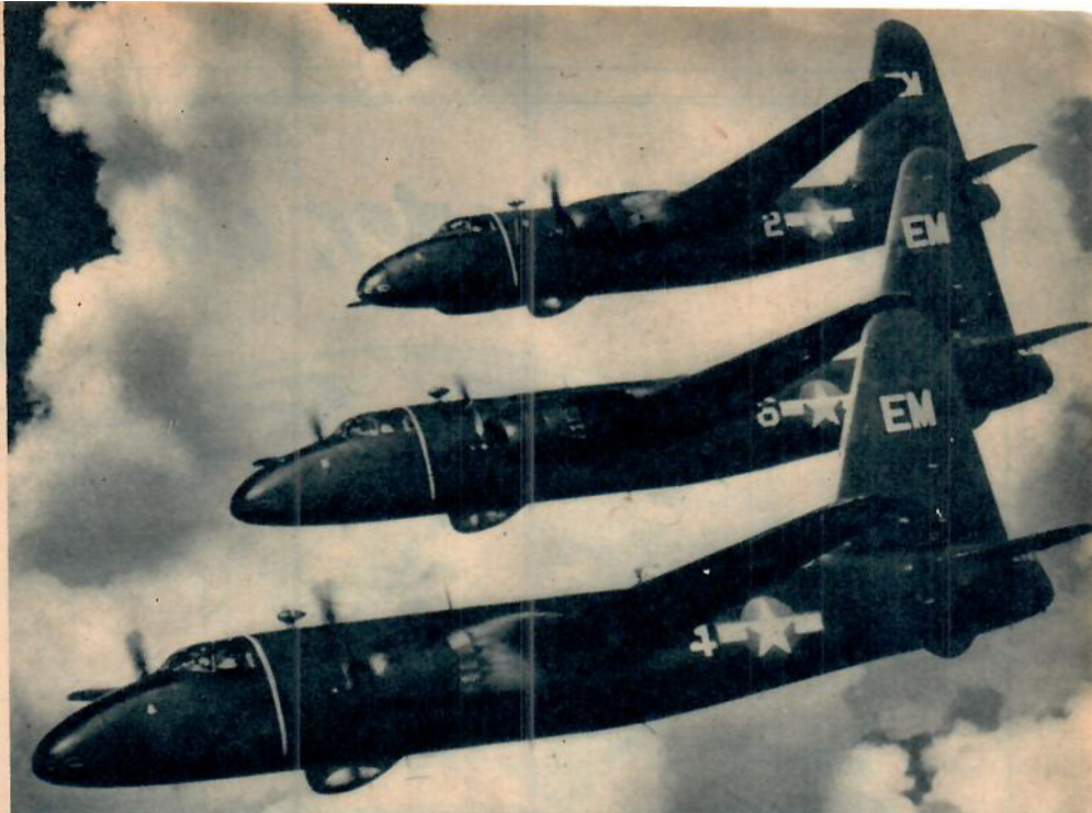
En vacker bild och f. ö. den första av det amerikanska spanings- och attackflygplanet P2V-2 i serieversion. P2V-2, som är världens största hangarfartygsbaserade flygplan, har en flygsträcka på hela 5.600 km med full beväpning. Toppfarten är 500 km/t. Det var ett plan av denna typ med extra bränsletankar som i höstas satte världsrekord i långdistansflygning genom att tillryggalägga sträckan Perth i Australien — Columbus i Ohio, drygt 18.000 km, på 55 timmar och 17 minuter. Amerikanska flottflyget har beställt 150 exemplar.
