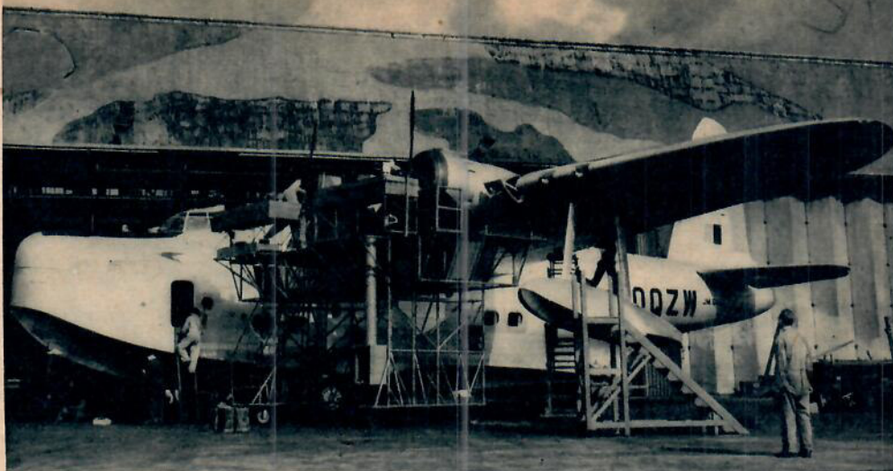
Ovan överses motorerna på en Short Hythe flygbåt i BOAC underhållsavdelning. Översynen sker från en av de specialkonstruerade bryggorna.
