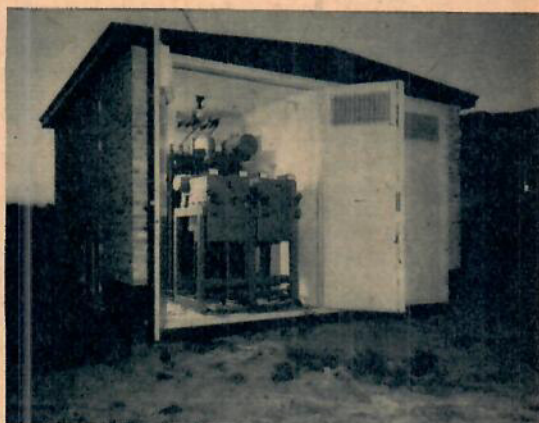
Ovan: En nätstation för nertransformering från 6.000 volt till 220 volt. Transformatorioser av denna typ finns bl. a. i Stockholms förstäder. — Nedan: Kontrollrummet i Elverkets huvudkontor i Stockholm. Ett stort antal mätare och kontrollapparater inregistrerar hela tiden kraftförbrukningen i Stockholm och härifrån kan man även följa allt som händer och sker på nätet hela vägen från Indalsälven och Dalälven.
