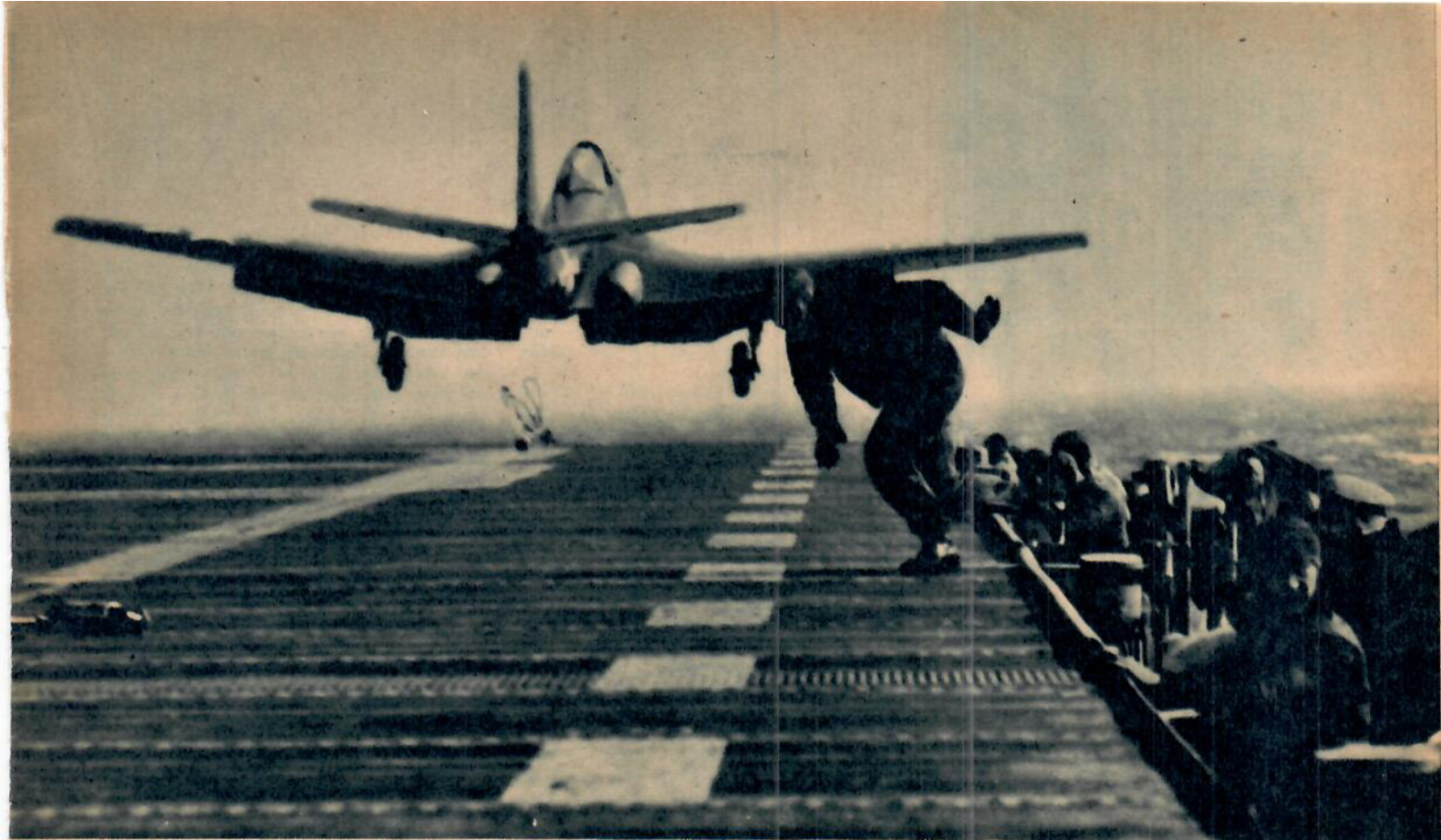
Ovan: Katapulten — av slangbågstyp — har gjort sitt, Phantoms reaktionsmotor har trätt i funktion och planet lyfter. Besättningen gör sig klar för nästa start.
