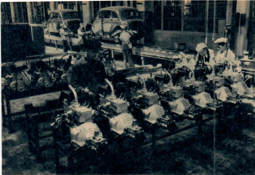
OPEL GAR IGEN. Den ryska folkbilen — »Lilla Moskva» — serietillverkas nu för fullt. Man behöver inte vara någon större bilkännare för att se vilken exakt kopia den är av tyskarnas Opel. Här granskar man de fyrcylindriga motorerna till fyrstäraren.
