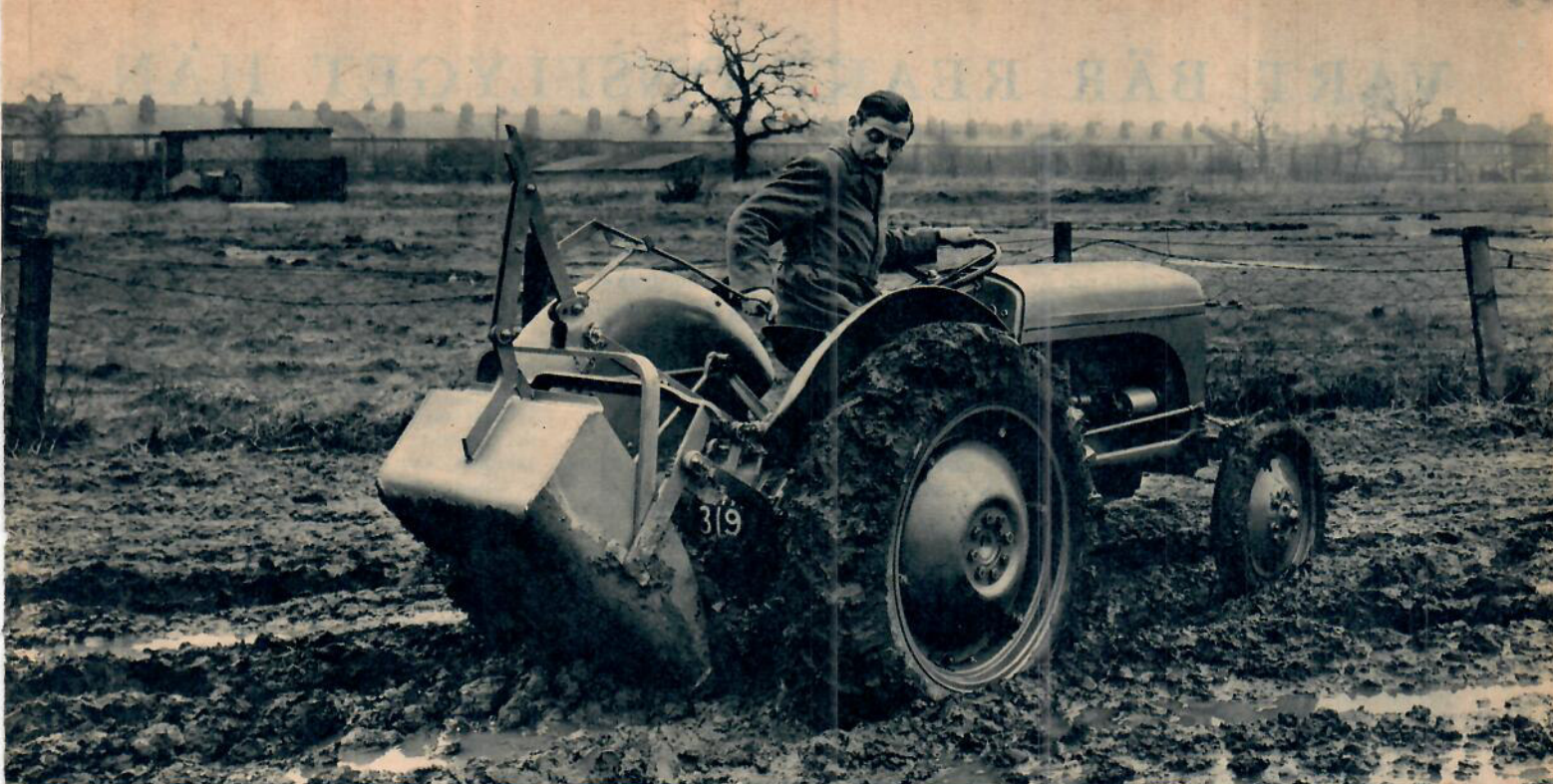
1) Fergusontraktorns jordskopa används bl. a. vid dränering.
