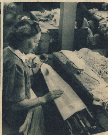
Nedan t. v.: Strumpskäften synas med genomskinliga »strykjärn» av plast. — Nedan t. h.: Kontroll av råstrumpan som utsätts för samma töjning som i verkligheten.
