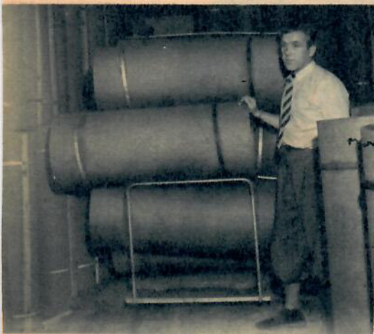
Ingenjör Harry Persson, Råsta Rørs fabriksledare, i torkrummet i vilket rören torkas i 70–80° C. Efter denna procedur behåller de sin böjda form. Här efter följer elektrisk limning och limtorkning.
