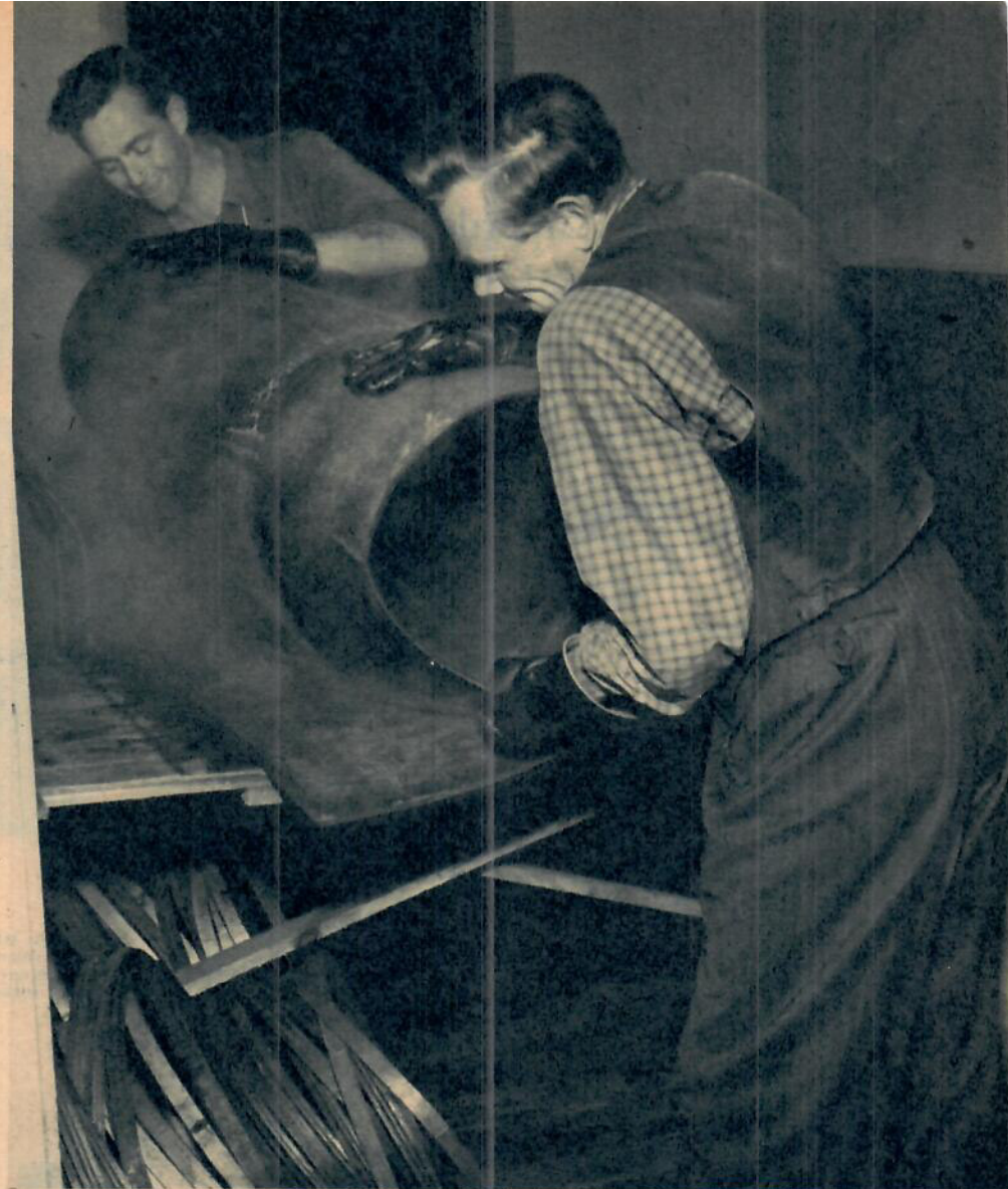
Ett hett kemiskt bad har gjort den sköra masoniten stark och elastisk. Två man kan böja den utan ansträngning.
