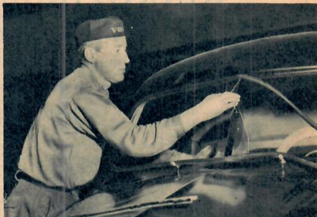
Insättning av fönster går på några sekunder. Man lägger rutan på sin plats, drar ut ett snöre som sitter i gummpackningen och fönstret sitter fast.
