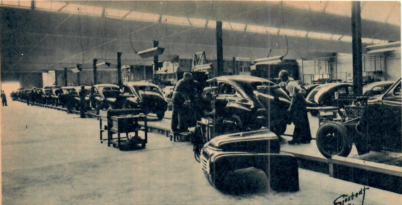
Huvudbanan i den stora monteringshallen. Omkring 15 vagnar kan samtidigt vara under arbete och de skjuts fram mellan de olika stationerna allt efter det att monteringen fortskrider.
