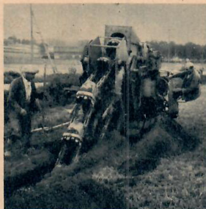
En engelsk dikningsmaskin, vars paterosterskopor gräver 600 meter dike per dag används vid nedläggningen av koaxialkabeln. Diket skall vara 30 cm brett och 75 cm djupt.
