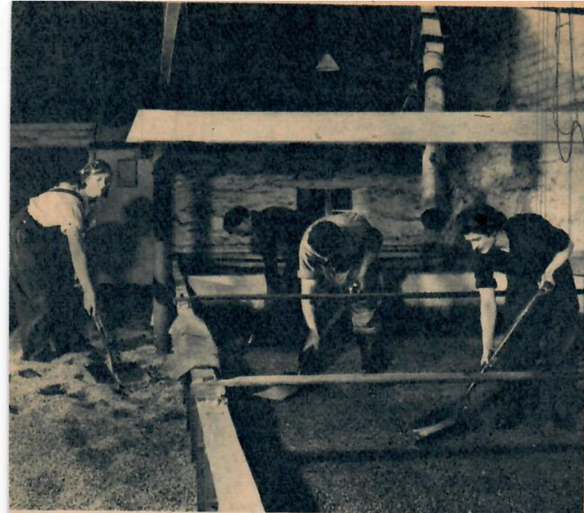
Första processen i framställningen av malt ur råg. Den torra rågen fuktas och sprids sedan ut för att ligga och gro.
