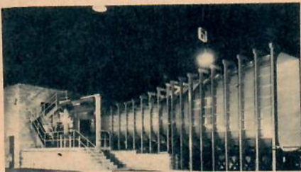
Rolls-Royce har byggt en vindtunnel speciellt för experiment med reaktionsdrivna modeller.
