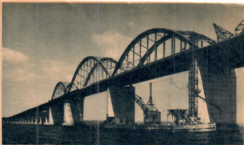
T. v.: Västerbron i Stockholm har två stora svetsade stålbågar på 168 meter och 204 meter och konstruktionen är ett bevis på att även stålbroar kan byggas lätta och eleganta. Även överbyggnaden är av svetsad stålkonstruktion och den bäres upp av ledade cylindriska stålpelare. — T. h.: Europas längsta bro. Storströmsbron i södra Danmark är en balkbro av stål för järnvägs- och biltrafik. Bron har sammanlagt 50 fack och en längd av 3.200 meter. Genomseglingsfacket i förgrunden har en spännvidd på 104—138—104 meter och en fri höjd av 26 meter. Byggnadstiden var 4\frac{1}{2} år.
