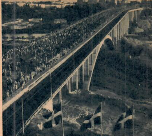
Stockholms nyaste högbro, Skanstullsbron, är en kombinerad balk- och valvbro i betong. Den har en längd av 574 meter och en bredd av 34 meter. För att bygga bron behövdes bl. a. 180.000 säckar cement och 1.800.000 kg stål.
