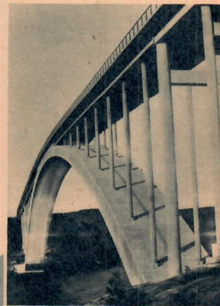
T. h.: Världens största betongbåge spänner sig med sina 264 meter över Ångermanälven vid Sandö. Bågen är 10 meter bred och 3—5 meter tjock och ihållig. Bron uppfördes 1942. — Nedan: The Golden Gate bridge i San Francisco — världens längsta och dyrbaraste hängbro — har sex körfiler i bredd och användes årligen av över tio miljoner bilar.
