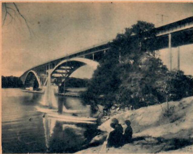
T. v.: Västerbron i Stockholm har två stora svetsade stålbågar på 168 meter och 204 meter och konstruktionen är ett bevis på att även stålbroar kan byggas lätta och eleganta. Även överbyggnaden är av svetsad stålkonstruktion och den bäres upp av ledade cylindriska stålpelare. — T. h.: Europas längsta bro. Storströmsbron i södra Danmark är en balkbro av stål för järnvägs- och biltrafik. Bron har sammanlagt 50 fack och en längd av 3.200 meter. Genomseglingsfacket i förgrunden har en spännvidd på 104—138—104 meter och en fri höjd av 26 meter. Byggnadstiden var 4\frac{1}{2} år.
