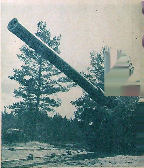
25 cm kanonen pekar höfvalt mot skyn. Den är kustartilleriets tyngsta rörliga pjäs och transporteras av tre bilar. Vikt 30 ton.
