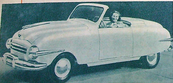
Playboy kan på några ögonblick förvandlas från kupé till cabriolet genom att fällas ner huven som är gjord i aluminium. Vagnen har en fyrcylindrig motor på 48 hk.
