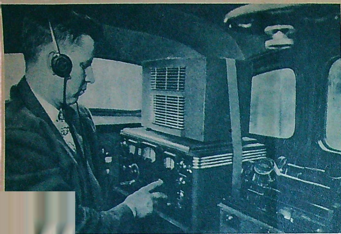
En pejlstation för lokalisering av illegala radiosändare monterad i en vanlig personbil.
