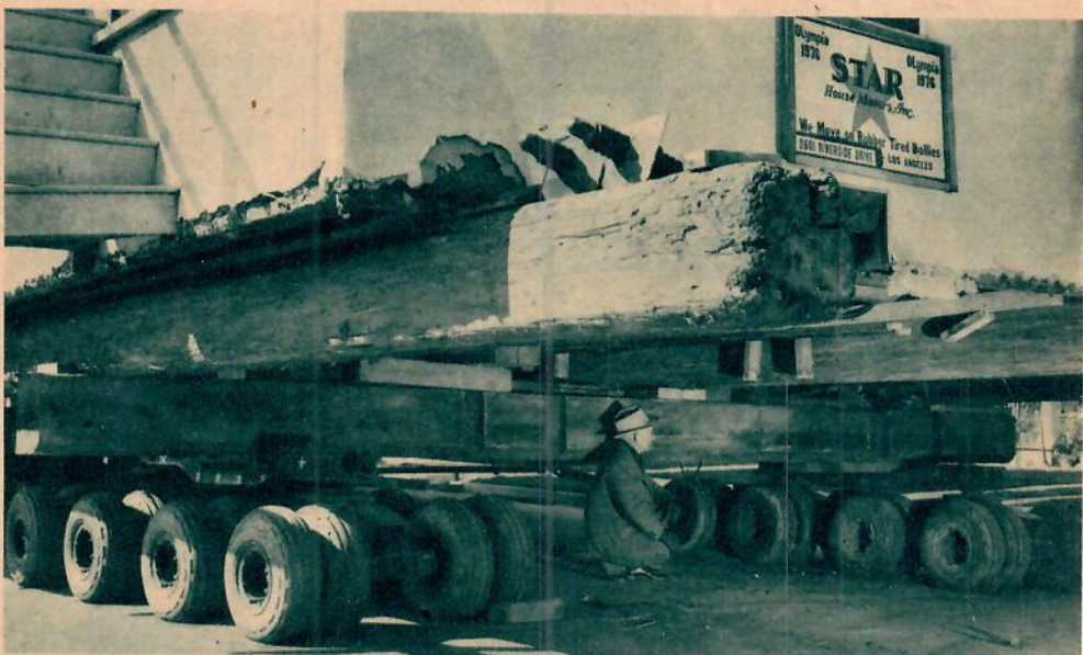
Nedan: Vid flyttningen av en brandstation av tegel använde man 30 hydrauliska domkrafter och 75 skruvdomkrafter. Ingen del av huset höjdes mer än 1/8 tum.
