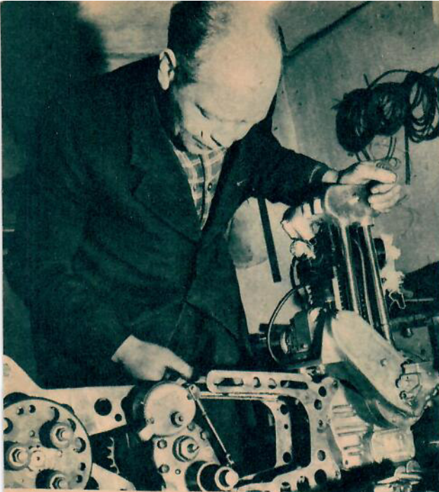
Motorn och växellådan är monterade i ett ställbart fundament som möjliggör snabb omväxling för olika konor. Här ses motoraggregatet under montering.
