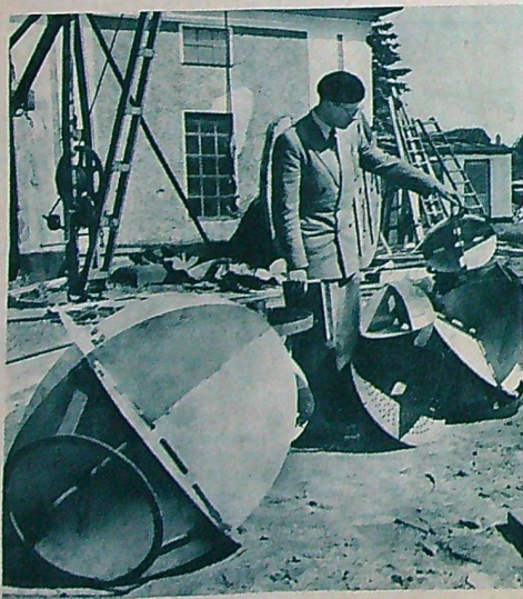
Fyringenjör Bengt Holm i Lotsstyrelsen demonstrerar sina radarreflektorer av typen hörnreflektor och avsedda att monteras på prickar och bojar. Träfoten skall möjliggöra det senare.
