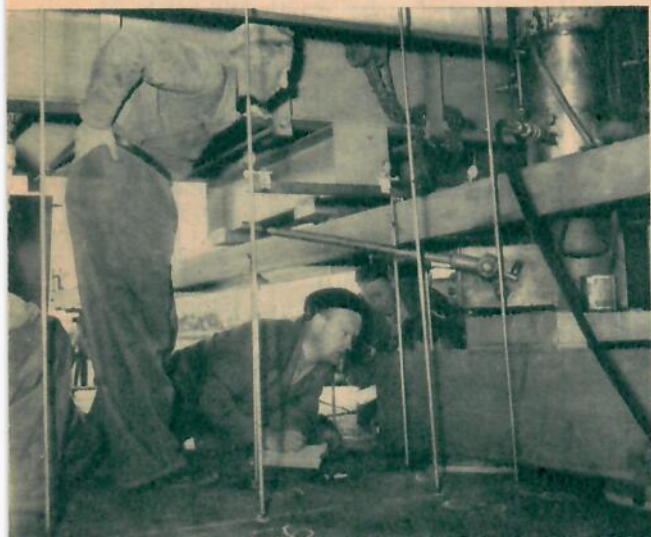
Ingenjör Tage Persson ligger på magen och mäter nedtryckningen av asfaltsbeläggningen i två mot varandra vinkelräta riktningar under en belastning som kan varieras i steg från 5 ton och ända upp till 100 ton.
