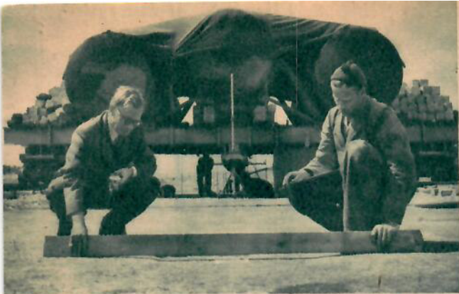
Ingenjörerna Bernell (t. v.) och Idebrand mäter den bestående deformationen, som i detta fall uppgått till ca 1 tum efter belastning med 100 ton. Den ytan duger inte.
