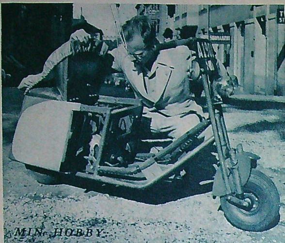
Här är konstruktören och byggaren, Axel Kock-Nommesen, med sin scooter. Den har en 98 cm 3 Villiers-motor som tagits från en lättviktare. Två-måners byggtid.
